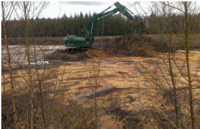
Foto, afgraven bouwvoor
